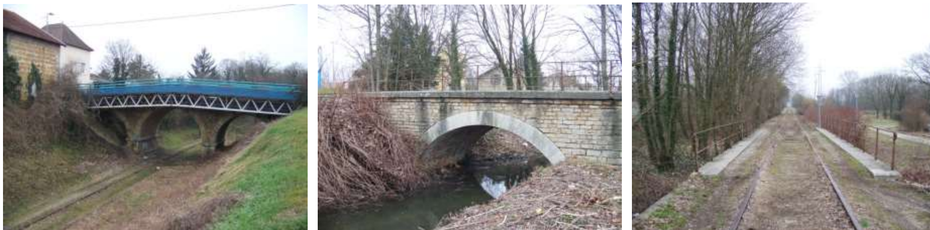
Illustration 11. Vue sur les ouvrages d'art n°4 et 5
