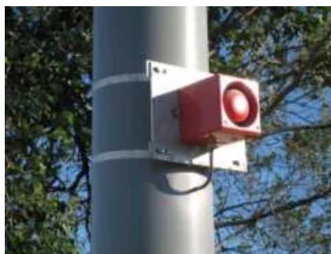
Illustration 20. Exemple de sirènes et lampes flash équipant la section en voie unique du tramway de Montpellier
