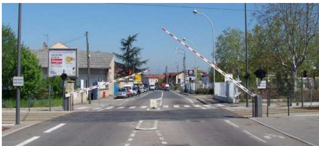
Illustration 3. Exemple d'intersections barrières (IBs) sur le T3
