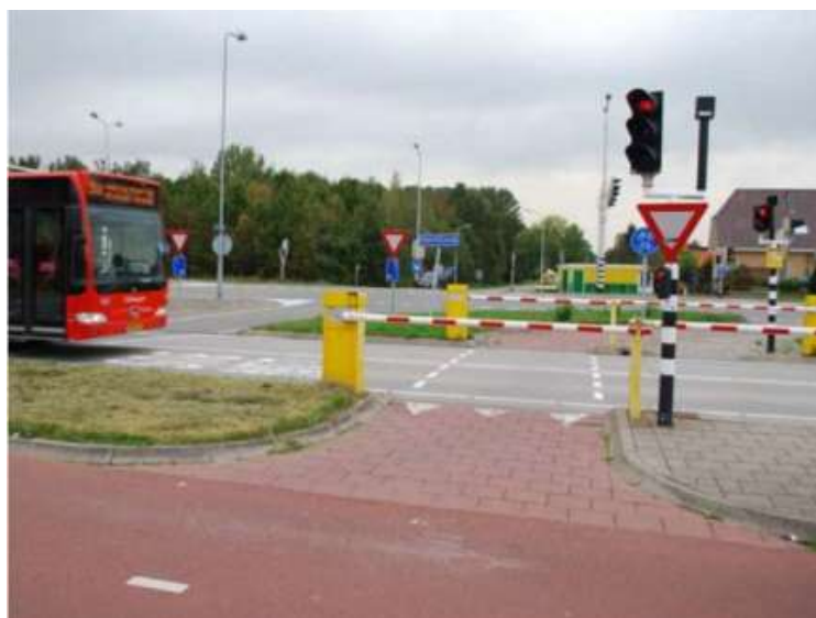
Illustration 14. Système d'installations barrières équipant le BHNS Zuidtangent à Amsterdam, Pays-Bas
