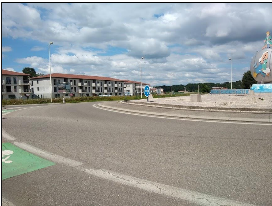
Des lots de logements en construction à Chavieu-Chavagneux, représentatifs de la croissance démographique soutenue de l'agglomération pontoise.
